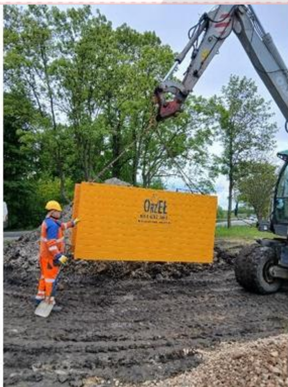
Fot. 1 Szalunek z uchwytami rozporowymi do stosowania w wykopach o głębokości do 3m
