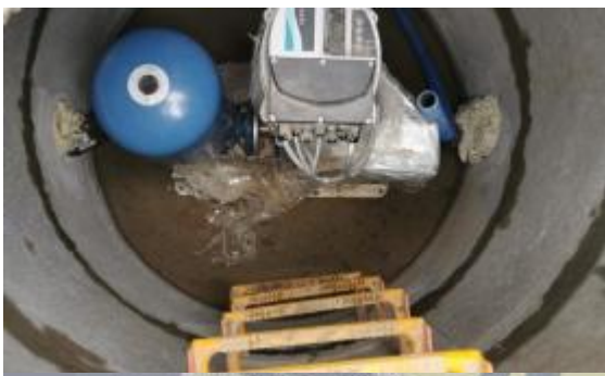
Budowa wodociągu DN 160 ok. 1300 mb Szymonów-Klęnow.
